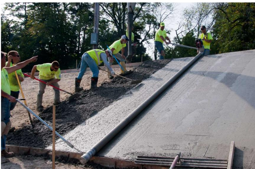
A inclinação nas curvas visa permitir manter altas velocidades nas curvas, de modo a que um ciclista siga pela pista, no seu trecho mais interno, como se estivesse numa reta infinita. Para isso, as inclinações máximas das curvas variam entre 40 e 45 graus, dependendo do raio de curva adotado e das velocidades de projeto (para provas de nível olímpico o requisito é da ordem de 70 km/h).
